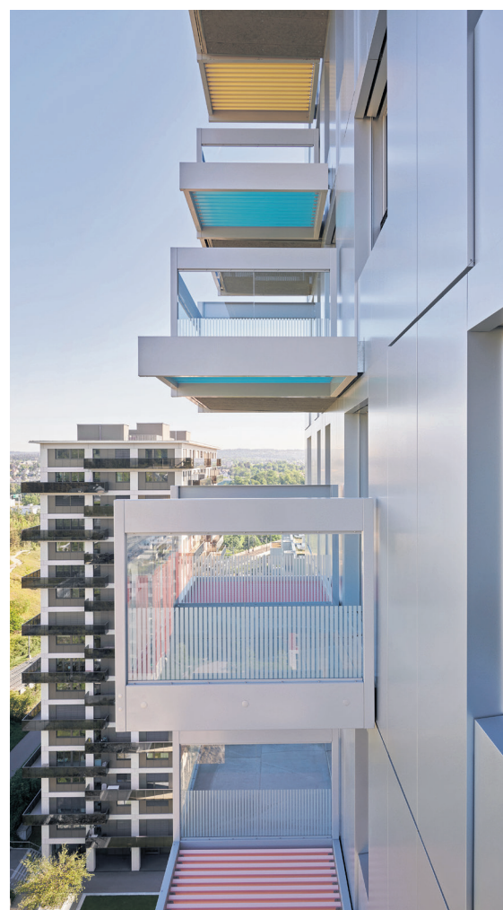
► Dank der erhöhten Geländer lässt sich auch in luftiger Höhe die Aussicht vom Balkon geniessen.
