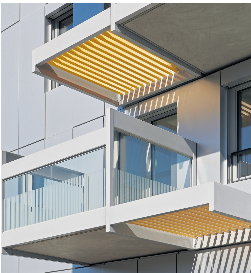
► Das Licht der Brise-Soleil sorgt für Feriengefühle.
