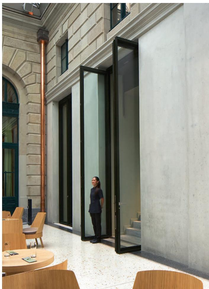
Türelement gegen den überdachten Posthof öffnend. Die Flügel stehen während des Restaurationsbetriebes offen. Die maximale Flügelhöhe beträgt 4,60 Meter. Elément de porte ouvrant sur la cour couverte de l'office de poste. Les vantaux restent ouverts pendant le service du restaurant. La hauteur de battant maximale est de 4,60 mètres.
