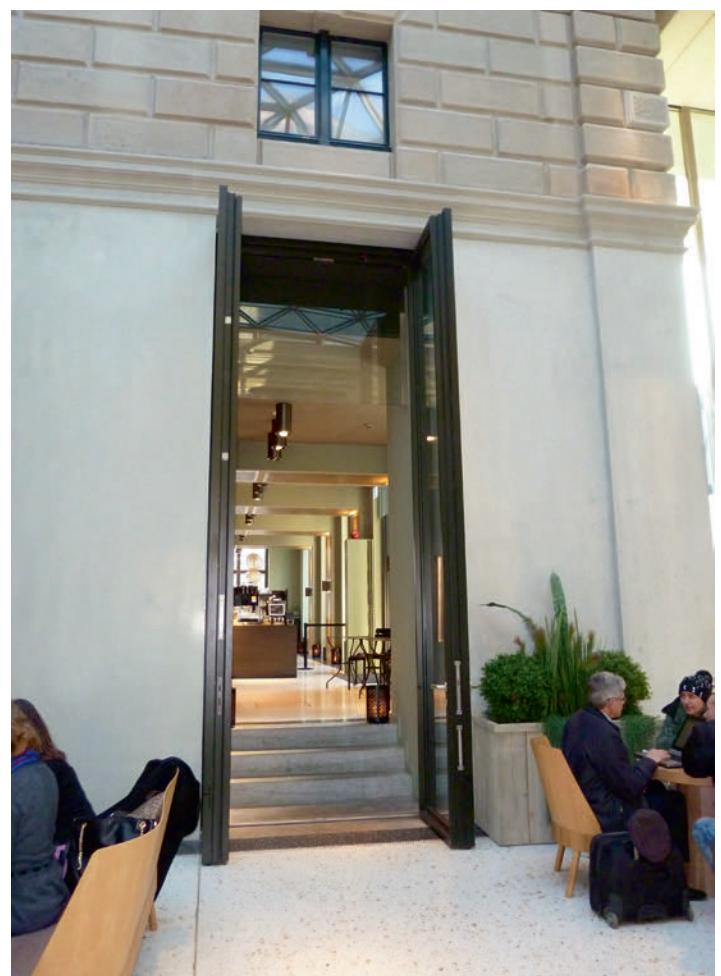
Die Flügel werden von je 2 Stück 3D-Anschweissband und einem angelaschweißten - auf den Bodentürschliesser wirkenden - Flachprofil geführt. Chaque battant est guidé par 2 paumelles 3D à souder et un profilé plat, soudé, qui manœuvre le ferme-porte au sol.
