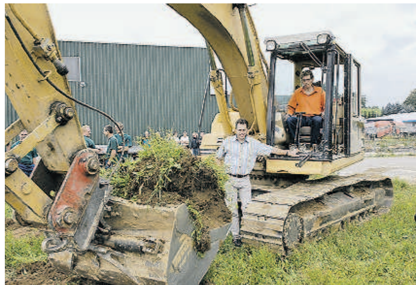
Philipp Blaser (links) und Heier Blaser (im Bagger) beim Spatenstich. Bild: Heinz Diener
