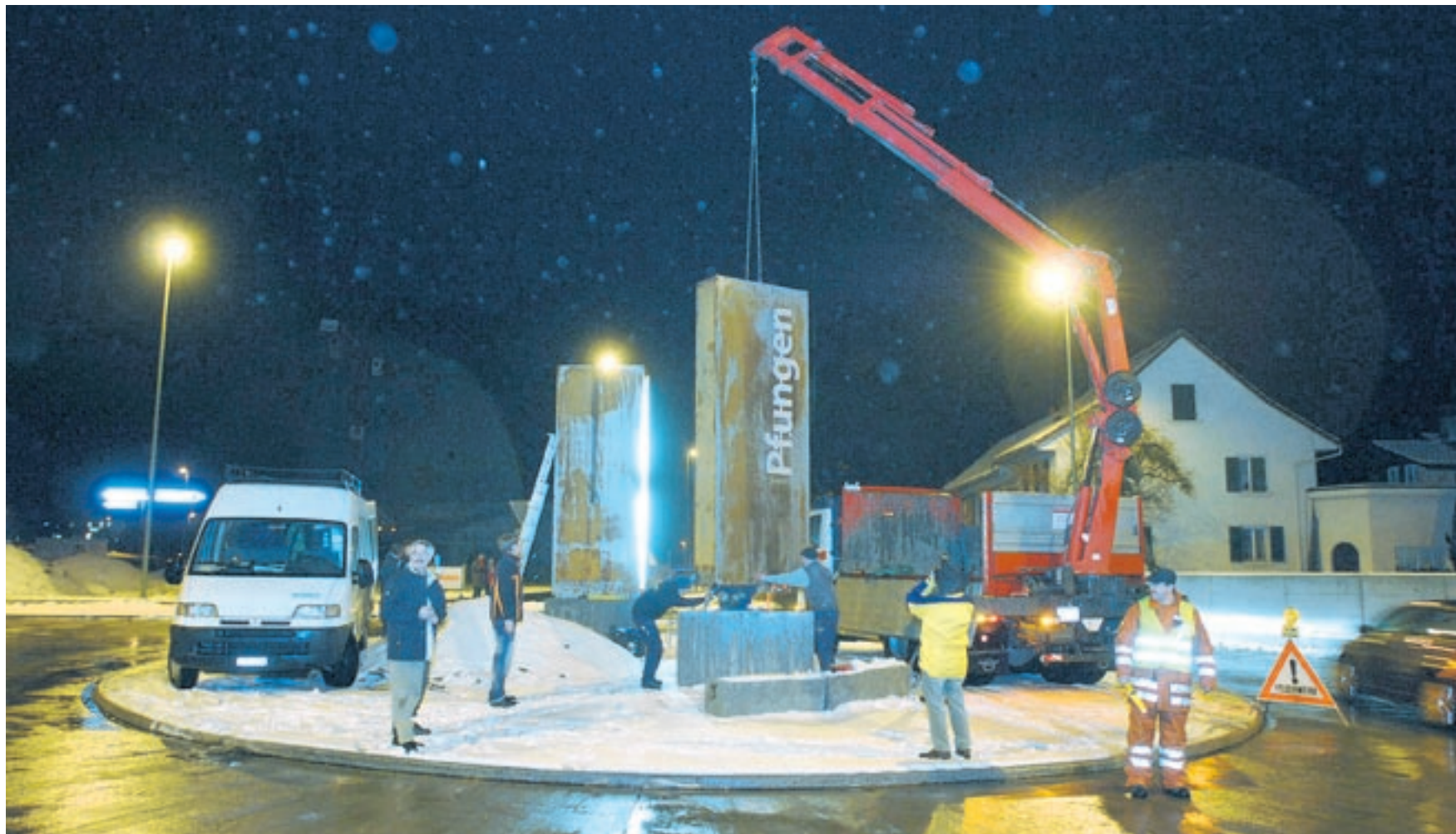
Tonnenschwere und rostige Gestaltungselemente des Kreisels: Die zweite Säule wird soeben mit dem Lastwagenkran in den Betonsockel eingepasst. Bild: Peter Würmli
