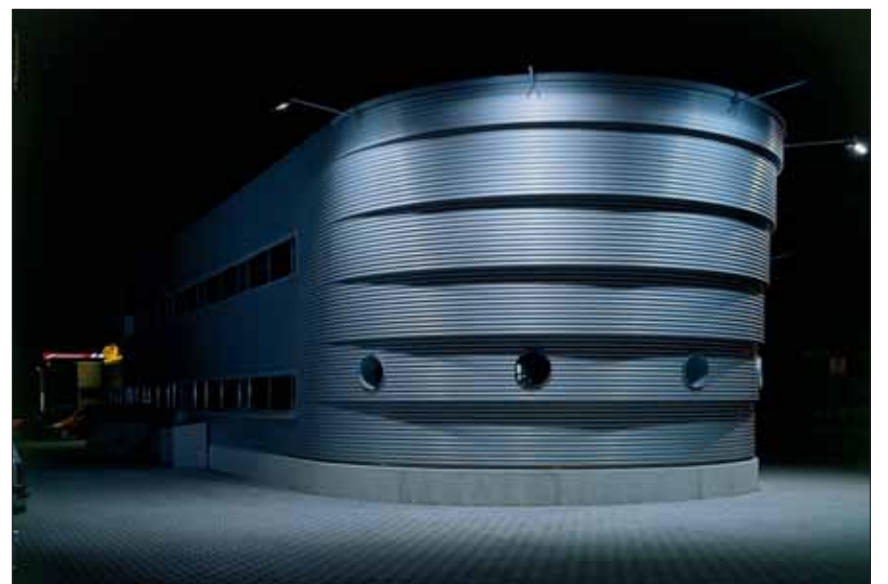
Grillen-Garage in Kleinandelfingen: Die futuristisch anmutende, abgestufte und teilweise runde Gebäudehülle verlangt Beachtung. Für diesen ganz auf betriebliche Effizienz ausgerichteten Gewerbebau wurde die Blaser Metallbau AG als teilautonome Generalunternehmerin beigezogen.
