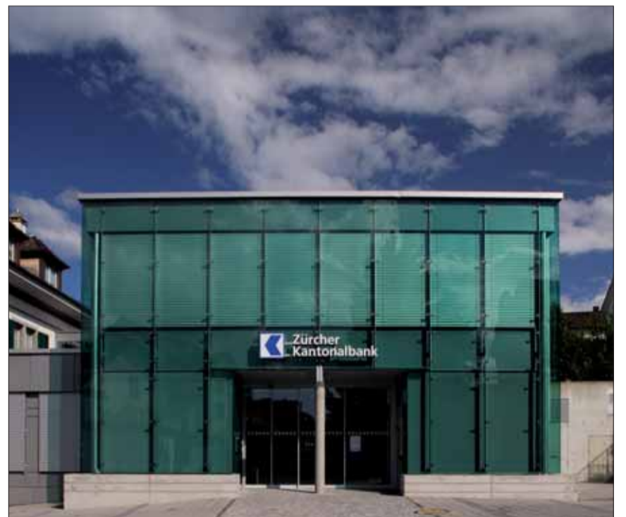
Zürcher Kantonalbank in Rüti: Die von der Blaser Metallbau AG realisierte Doppelhaut-Fassade erfüllt alle Sicherheitsanforderungen einer Bank.
