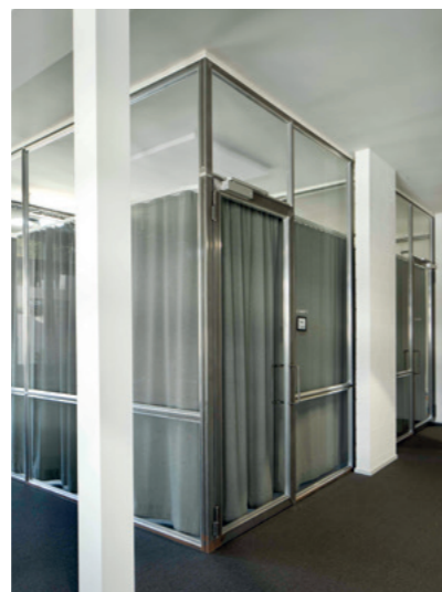
Bürotrennwand mit Türe
